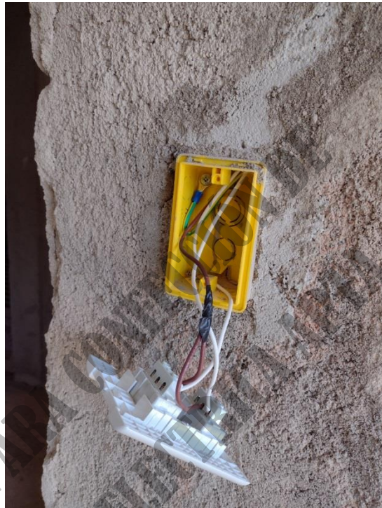
Interrupción de dos puntos (abierto)
